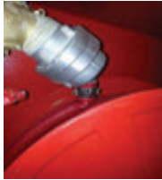
Yavru hortumunda burkulma olan yangın dolabı
