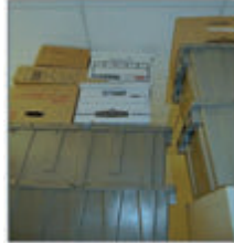
Sprinklerin koruma alanına depolama yapılması
