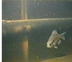
İçerisinde veya su yüzünde pislik, boya kalıntıları, yabancı cisimler bulunan yangın suyu
